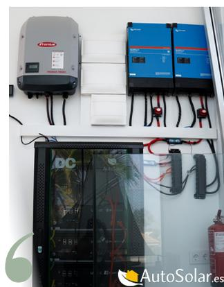
Las instalaciones AC Coupling de acoplamiento en corriente alterna funcionan tanto con conexión a red como de manera aislada, tratándose de una magnífica opción para viviendas y empresas, que tengan un consumo energético elevado, tanto por el día como por la noche, así como en horas de
